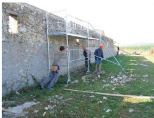
Un échafaudage a été installé pour le travail de stabilisation des hauts de murs. Des tréteaux de maçon avec bastaings ont été installés et sécurisés autour de la chapelle pour la reconstruction des murs.
